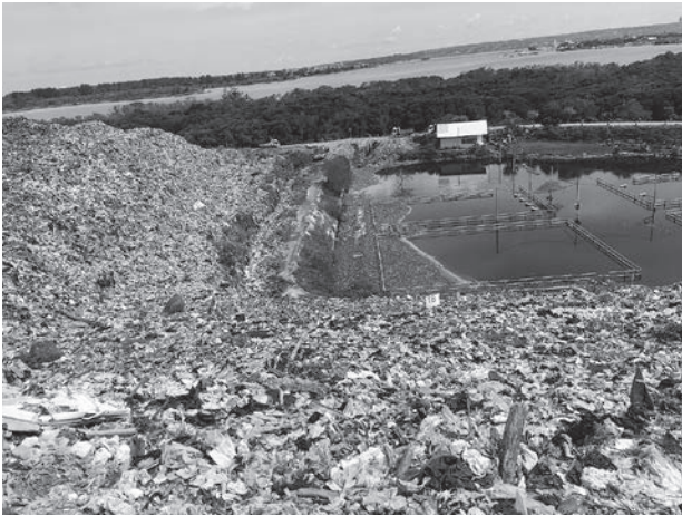
写真-2 スウン埋立処分場（バリ州デンパサル市）：バリ島沿岸部に建設された埋立処分場では、浸出水処理施設は機能していない。マングローブ林を挟んだビーチリゾート地区（写真上部）への浸出水やプラごみの流出が懸念される。
