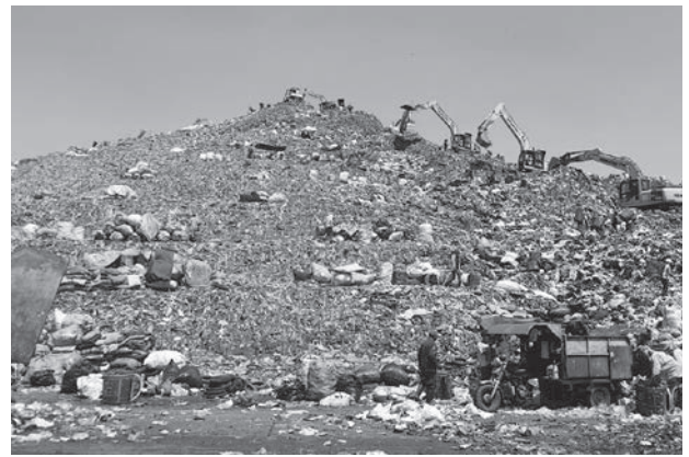
写真-1 バンタルグバン埋立処分場(西ジャワ州プカシ市):首都ジャカルタ特別州から毎日7500トンものゴミを受け入れる。30メートルにも及ぶゴミ山の頂上に向けて、7台のシャベルカーがゴミをバケツリレーで運搬している。
