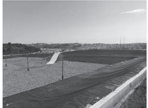
写真-3 マンガール埋立処分場（バリクパパン市）：2019年に供用開始された9ヘクタールの処分場。
